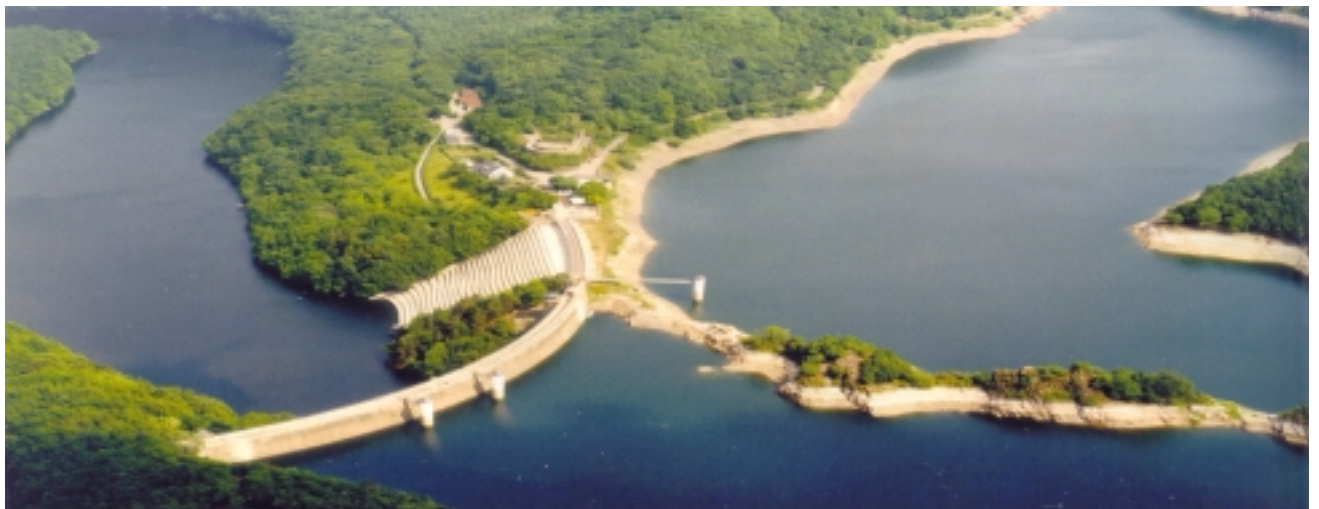
Barrage de Urft en Allemagne
