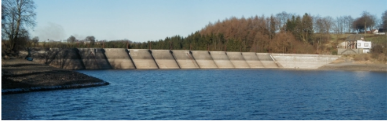
Barrage de Butgenbach . Vue amont
